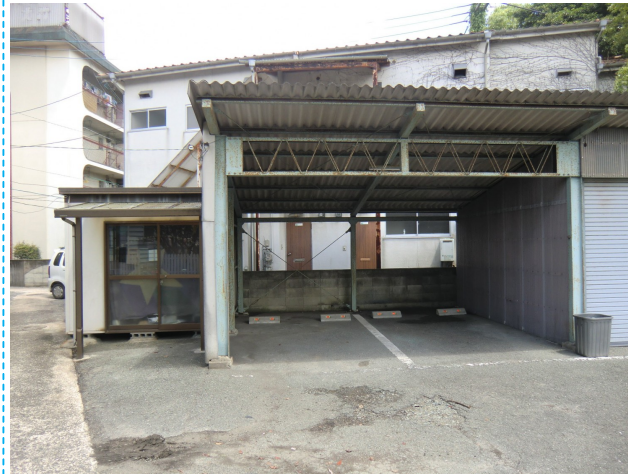
屋根付き駐車場
