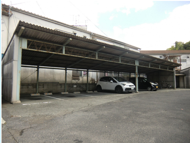
屋根付き駐車場
