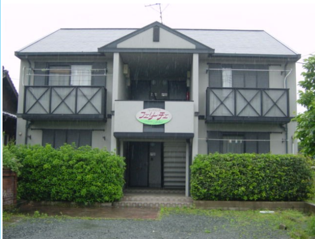
wi-fi・宅配BOX設置♪
