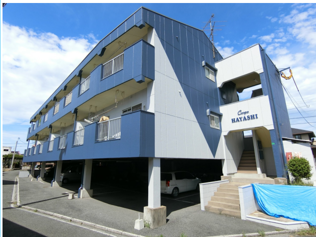
1階が駐車場スペースです。
