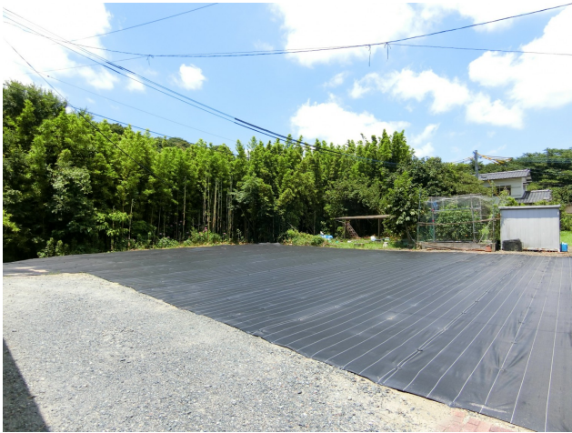
防草シートを引いています。
