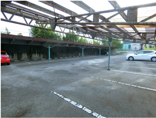
屋根付き駐車場（鉄骨造）
